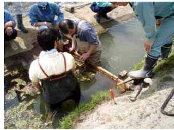
魚道の設置状況（堰板の設置）
